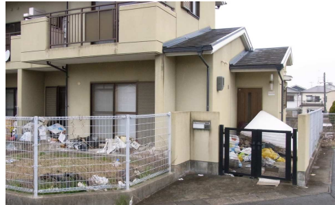
廃墟化！3月7日に不法投棄が横行する改良住宅を視察
