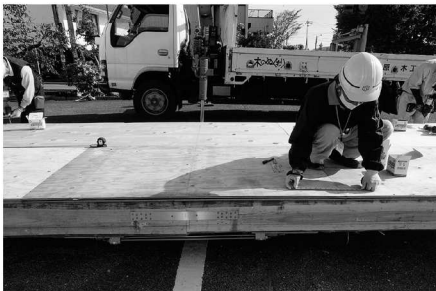
▲写真④ 床組みの構築
