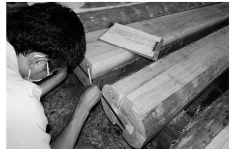
▲写真⑮ 十字目違い継手の計測
