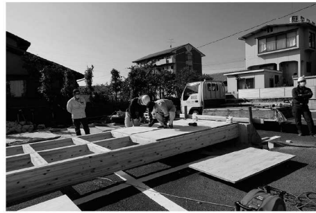
▲写真② 集成材の1本材タイプの製作
