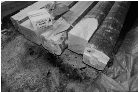
▲写真⑬ 竹下棟梁による十字目違い継手の刻み
