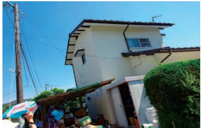
写真8 熊本地震被害状況（その2）
