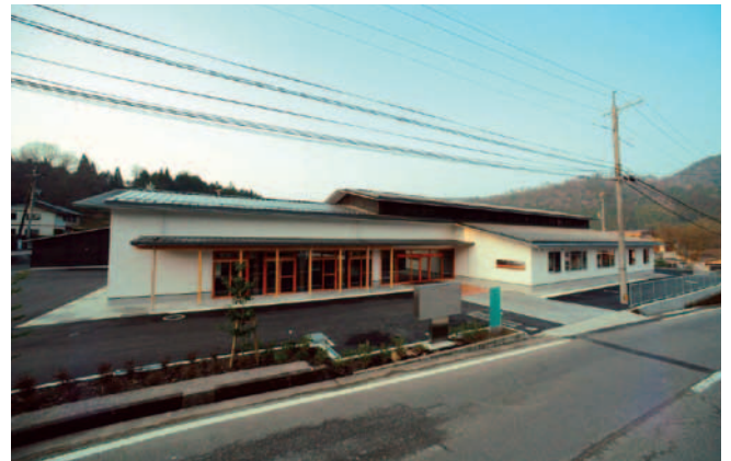
写真 18 本郷支所ラスモルタル外壁完成 (1)
