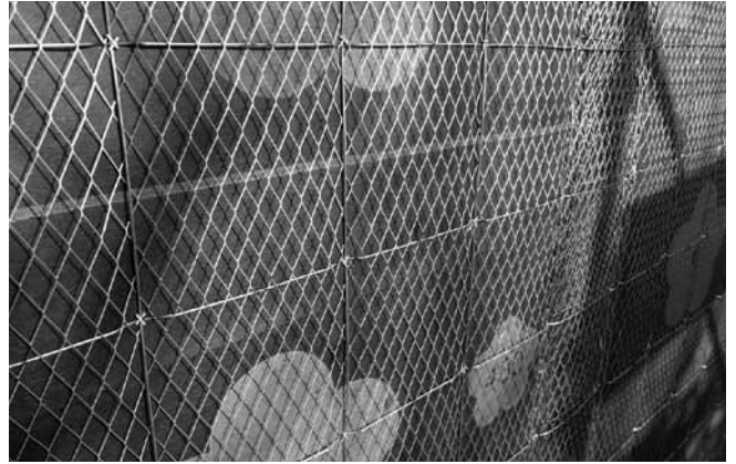
写真 12 千里聖三一教会のラスモルタル外壁の施工状況 (2)
