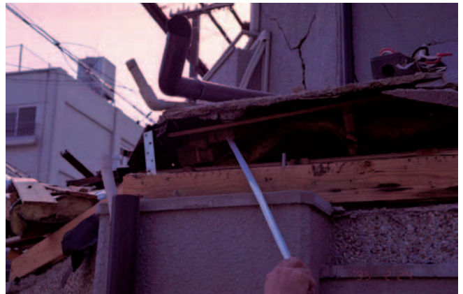
写真 1 阪神淡路大震災被害状況（その 1）
