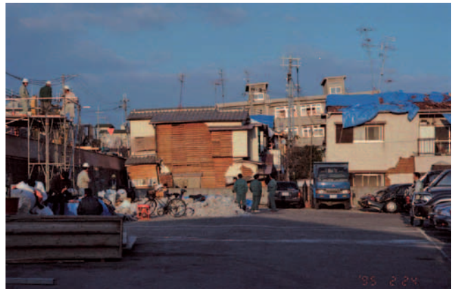
写真 2 阪神淡路大震災被害状況（その 2）
