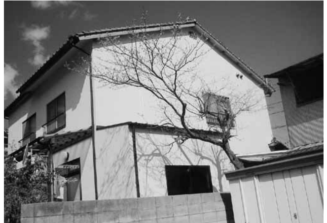
写真21 耐震補強事例完成写真（その1）
