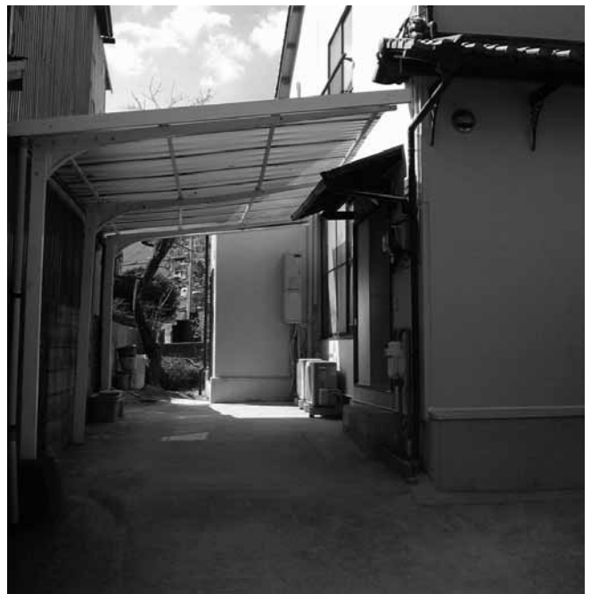
写真22 耐震補強事例完成写真（その2）
