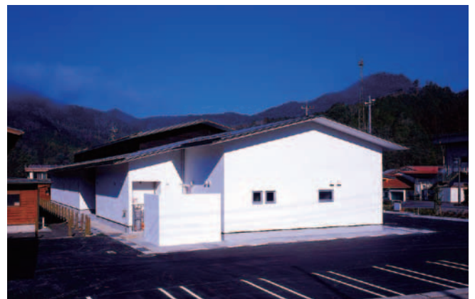
写真 20 本郷支所ラスモルタル外壁完成 (3)
