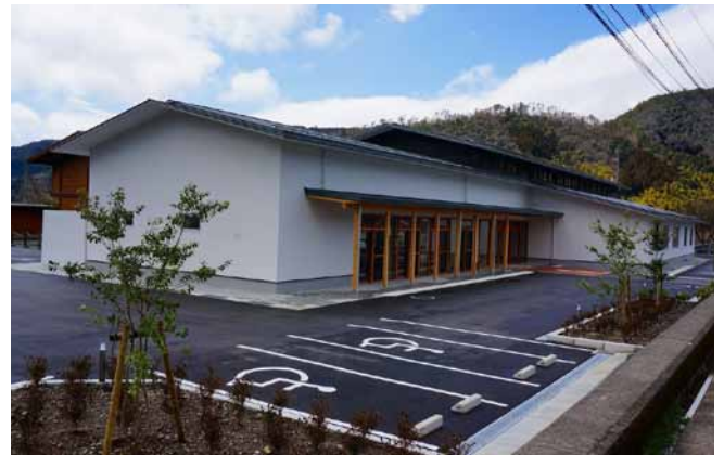
写真 19 本郷支所ラスモルタル外壁完成 (2)
