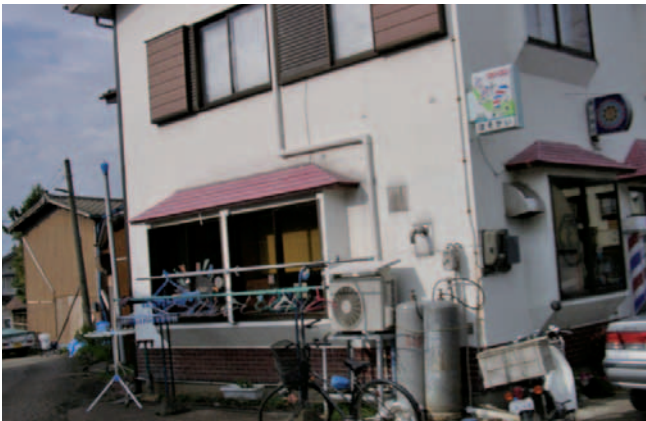
写真4 中越地震被害状況（その2）
