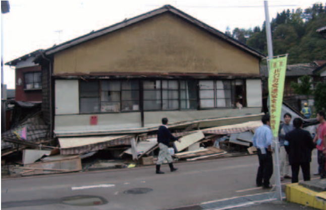
写真3 中越地震被害状況（その1）
